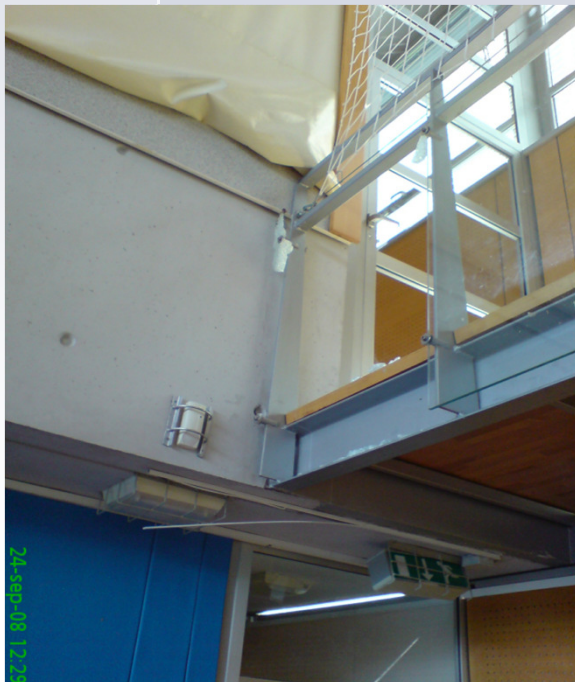
Nepravilna izbira stekla za nadglavno zasteklitev
