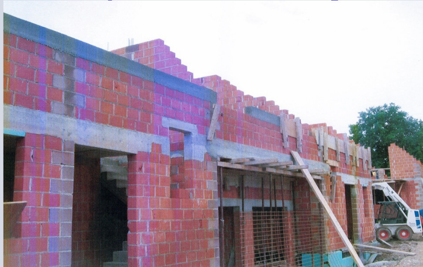
Prekinjenost vodoravnih a.b. vezi in opustitev izvedbe zaključnih vezi
