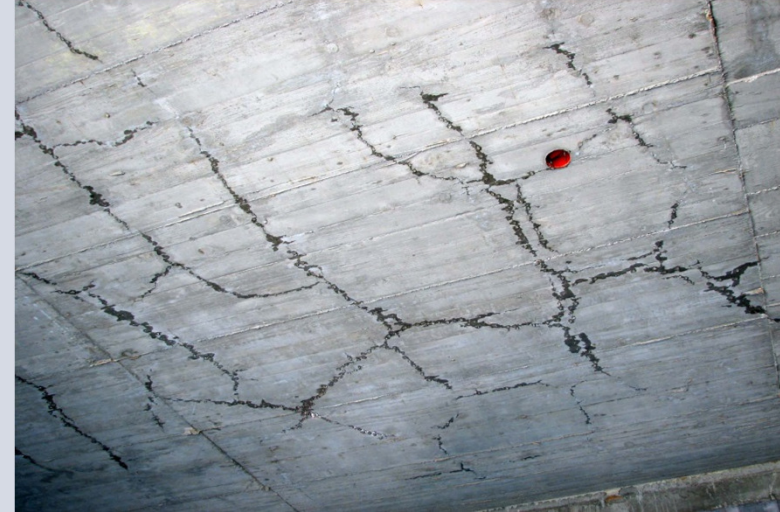
Pomanjkljiva nega betona
